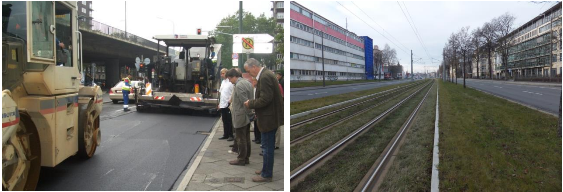
Fotos: Einbau lärmindernder Belag in Düsseldorf, Rasengleis Zwickauer Straße Chemnitz
