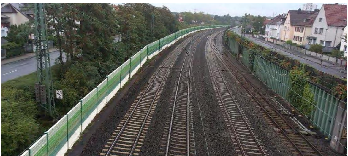
Foto: Beispiel für Lärmschutz entlang einer Haupteisenbahnstrecke
