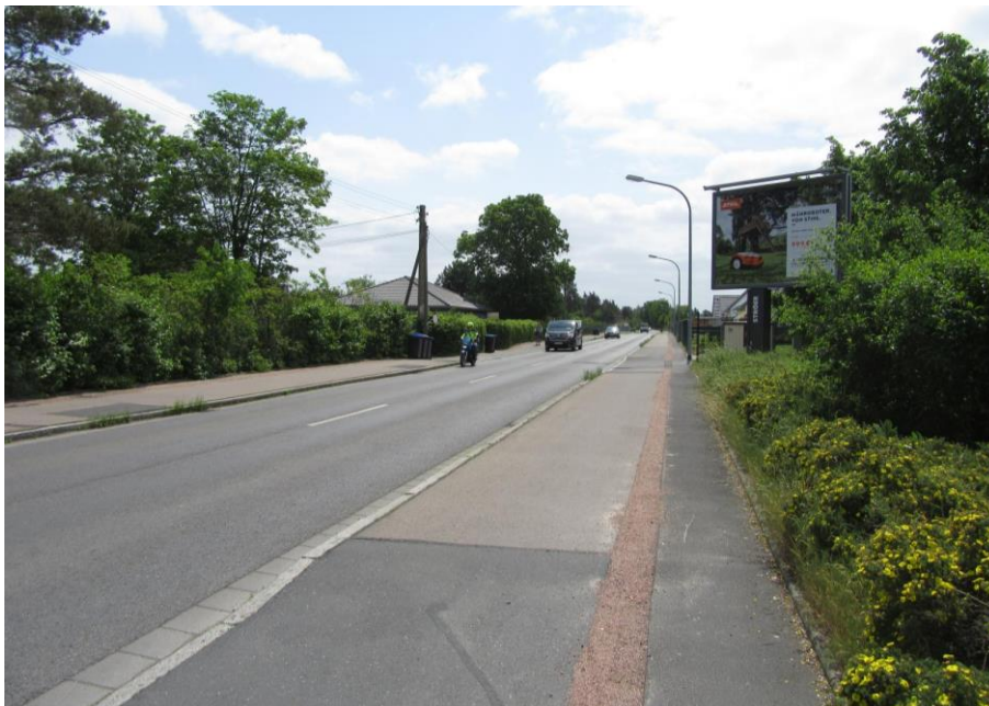
Foto: Ortsdurchfahrt S 84 (Dresdner Straße)
