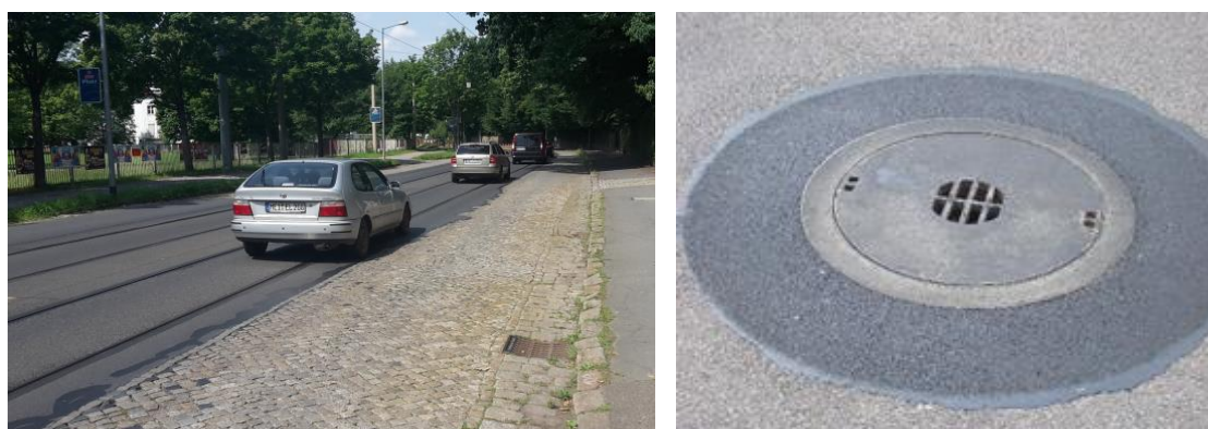
Fotos: Granitkleinpflaster in der Fahrbahn mit erhöhter Lärmemission und Gussasphalt-Schachtabdeckung mit niedriger Lärmemission
