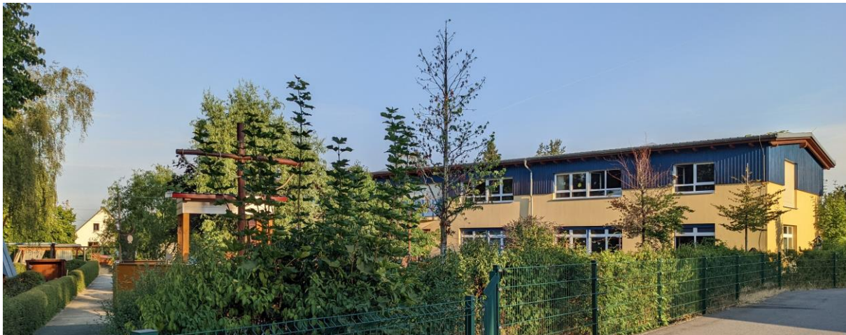
Standort Dresdner Straße
