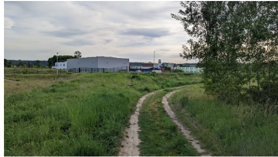
Gewerbestandort in Neusörnnewitz
